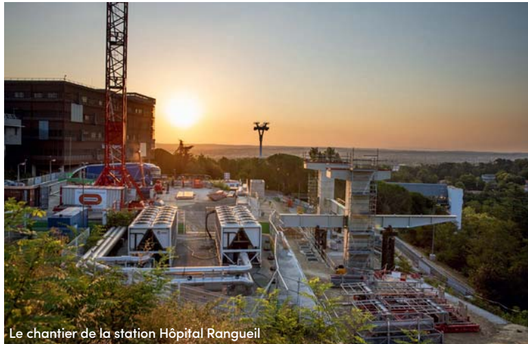
Le chantier de la station Hôpital Rangueil
