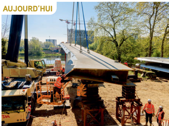
Chantier de la passerelle Rapas vu de l'île du Ramier
